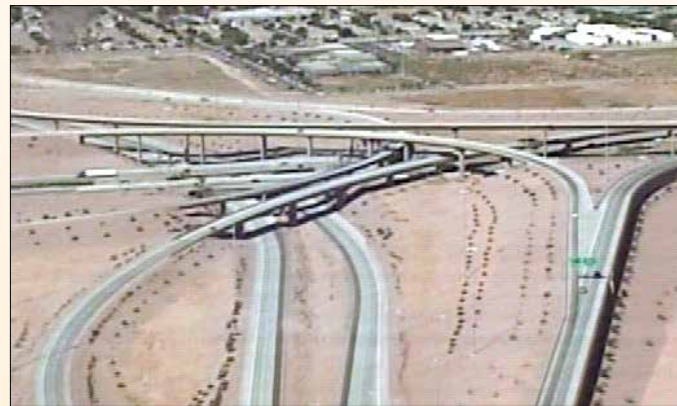
(d) SR 202L at I-10, looking west
