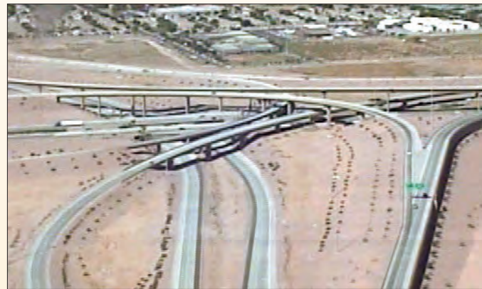
(d) SR 202L at I-10, looking west
